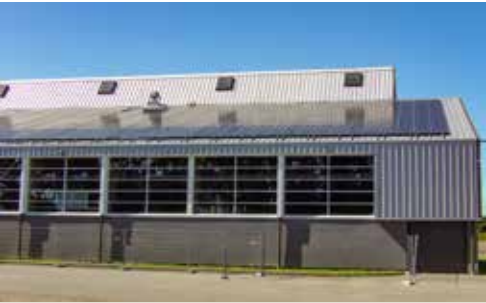
Pose de 280 panneaux photovoltaïques sur le toit de la salle de sports Pierre Duron (côté parking) à l'initiative de Roannais Agglomération. Production électrique estimée : 135 MWh/an.
