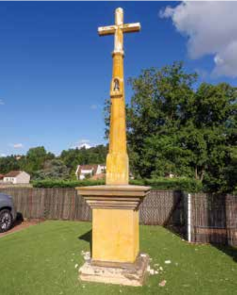
Rénovation complète du socle de la croix du bourg de Vernay
