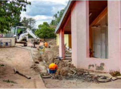
Cour de l'école élémentaire : changement des conduites d'eaux pluviales et d'eaux usées puis remise en état de la cour ; consolidation des arêtes des façades.
