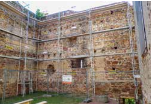
Consolidation du haut des remparts de la cour de l'église de Vernay
