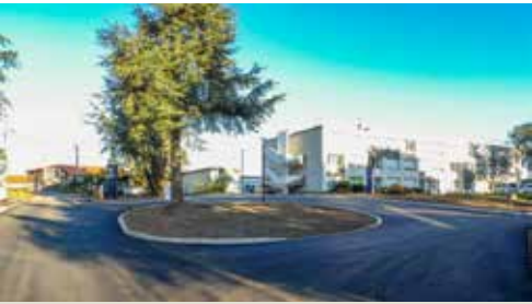
Création d'une aire de retournement juste à l'entrée de la clinique des Monts du Forez, afin de permettre aux bus électriques de desservir le quartier de Chassignol. Un point d'éclairage public a été ajouté, le gros arbre a pu être conservé. Le coût de ces travaux a été pris en charge, à parts égales, par le groupe propriétaire de la clinique, Roannais Agglomération et la commune.
