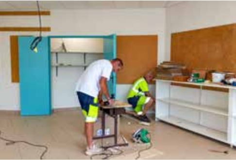
Rénovation de deux salles de classes de l'école élémentaire : peintures murales, pose de faux plafonds, changement de l'éclairage avec des pavés équipés d'ampoules LED, installation d'une ventilation. Tous ces travaux ont été effectués par les agents des services techniques municipaux.
